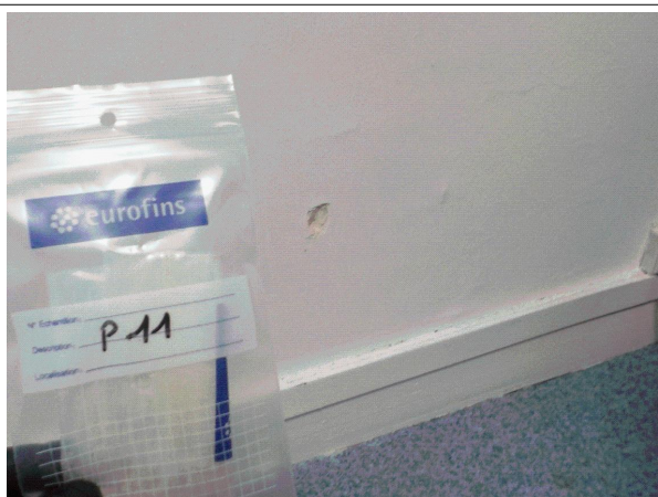
Prélèvement - P011 : R+1 / Bureau 101-1 - Enduit- (Présence d'amiante)
